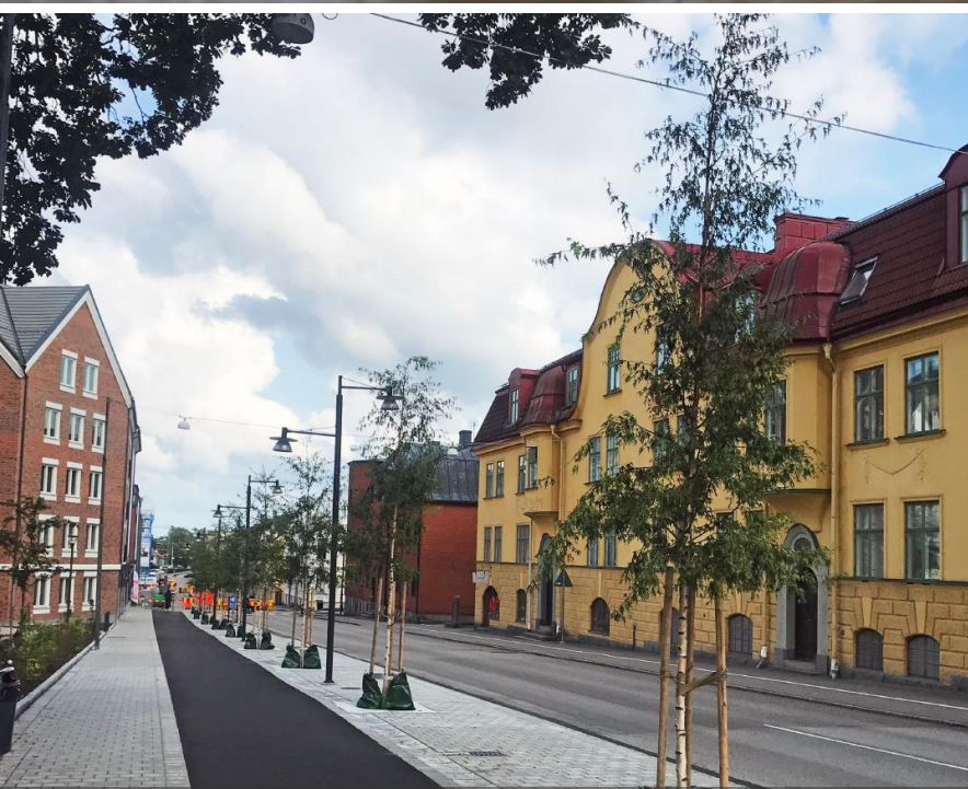
Träd i hårdgjord yta. Södra järnvägsgatan, Växjö. Under betongplattor genomgående öppet förstärkningslager med biokol, under G/C-väg öppet förstärkningslager. Dagvatten leds in via rännor till luftdagvattenbrunnar. Foto: Örjan Stål från "Levande gaturum – en handbok i Blågröngrå system" av Edge
